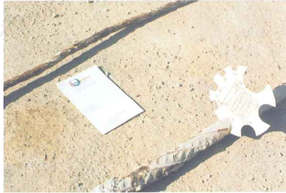
Figura 12.- Toma de muestras de armadura para su ensayo.
