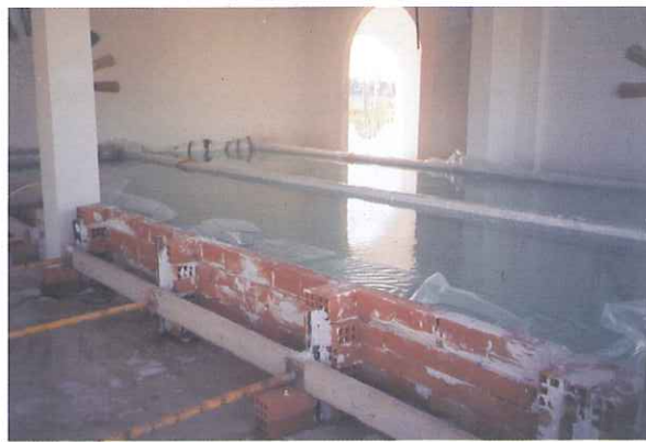
Figura 13.- Aspecto general de la balsa de agua del lastre de una prueba de carga de forjado.
