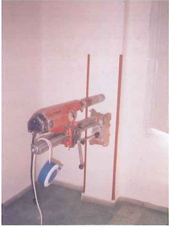
Figura 5.- Proceso de extracción de probetas testigo, sobre pilar de hormigón.
