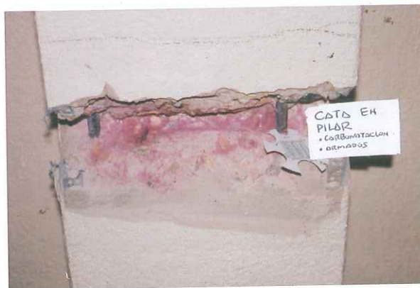
Figura 9.- Cata en pilar de hormigón para comprobar el estado y situación de la armadura, así como la profundidad de carbonatación.
