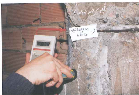
Figura 8.- Comprobación del potencial de corrosión de las armaduras de un pilar.
