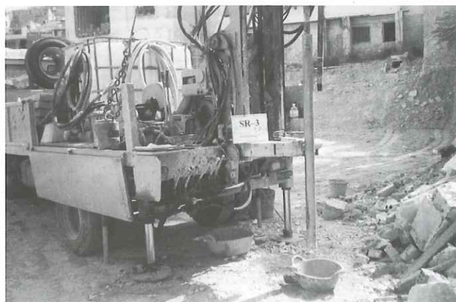
Detalle del equipo de sondeos durante la realización de un sondeo mecánico. Véase la batería de recuperación, mediante la cual se efectúa la toma de muestras.
