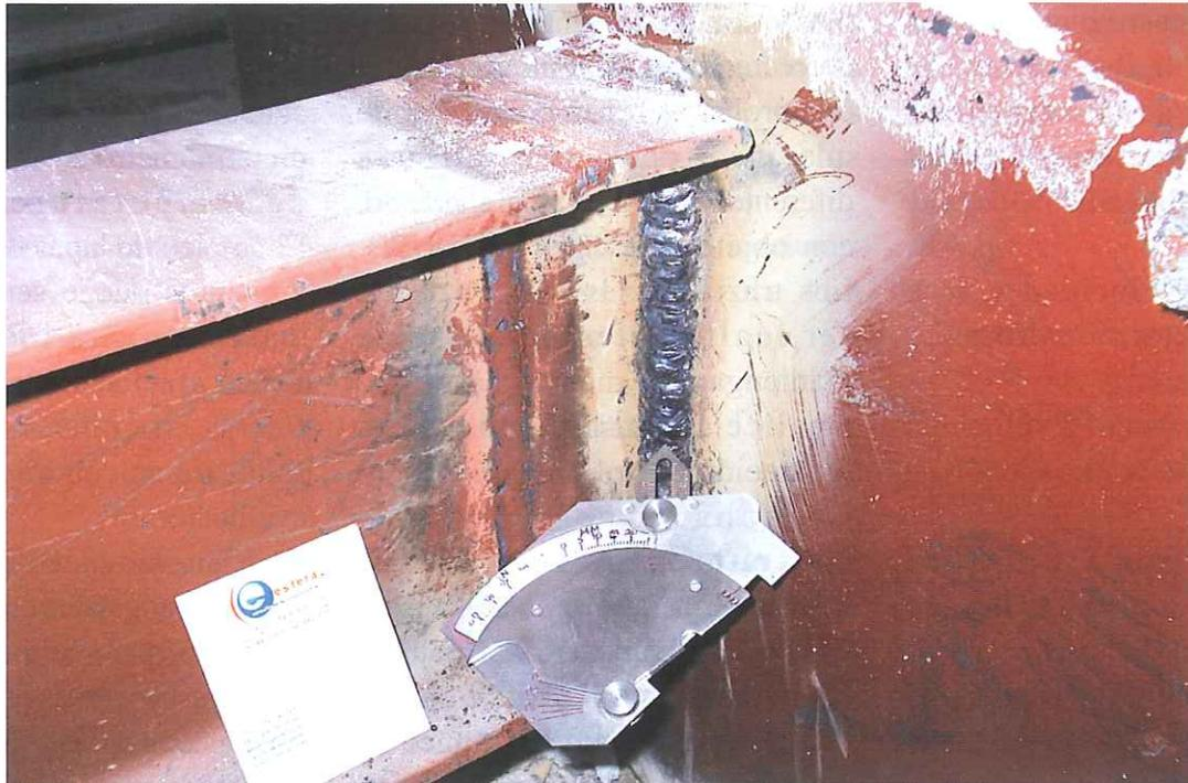
Aspecto general de un cordón de soldaduras sobre el que se está procediendo a la medición de su profundidad de garganta, en un encuentro estructural. Además del control geométrico del cordón, se debe controlar la ejecución de la obra. Véase el deficiente aspecto que presenta el nudo estructural
