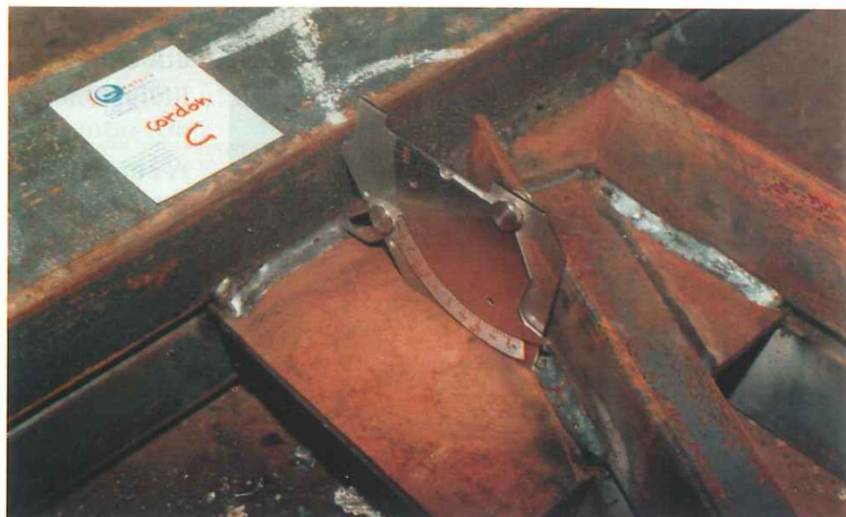
Aspecto general de un cordón de soldaduras sobre el que se está procediendo a la medición de su profundidad de garganta, en una cercha de cubierta de una nave industrial.
