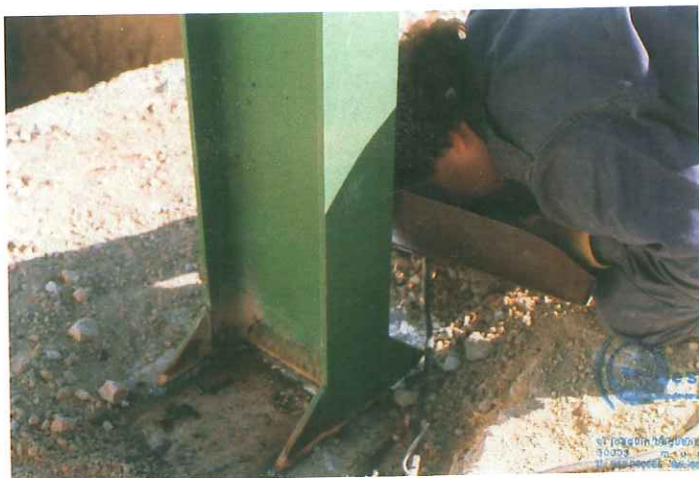
Aspecto general de un operario, tras la comprobación de su acreditación oficial, en un proceso de soldadura, realizando un cordón en posición horizontal, en un pórtico de estructura metálica.
