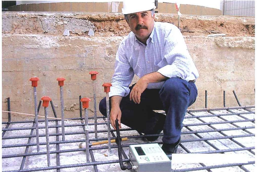
*Aspecto general del proceso de ensayo de un grupo de pilotes. Véase el procedimiento que se sigue, localización de la cabeza del pilote y la instrumentalización para el inicio del ensayo (Método Eco)*
