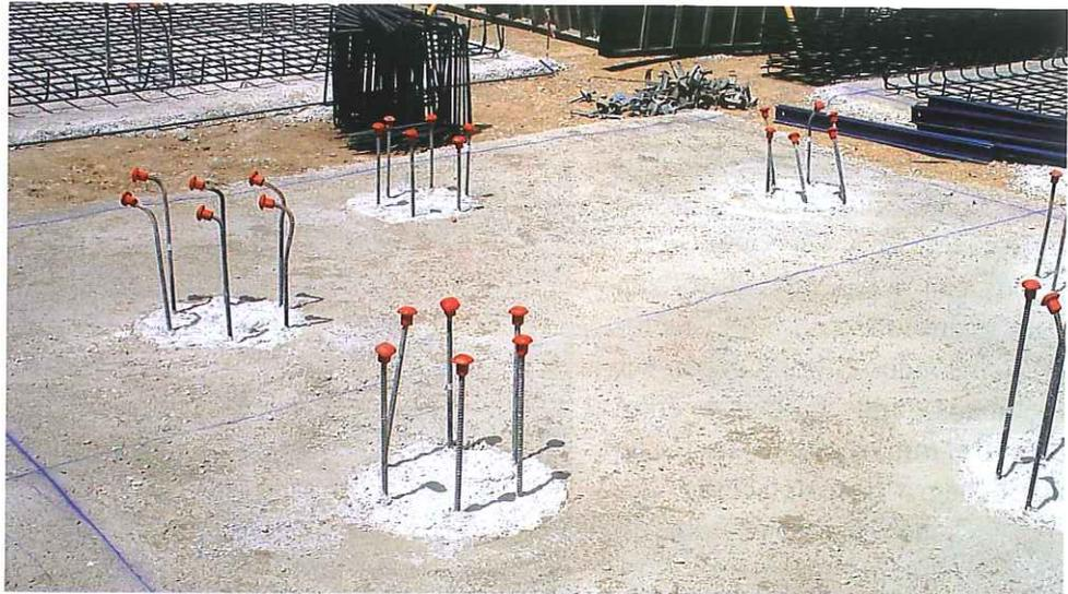
*Aspecto general y detalle del encabezado de un grupo de pilotes, para una losa armada, en un edificio industrial. Véase el detalle de la cabeza de unos de los pilotes, preparado para el inicio de los Ensayos de Control de Calidad*
