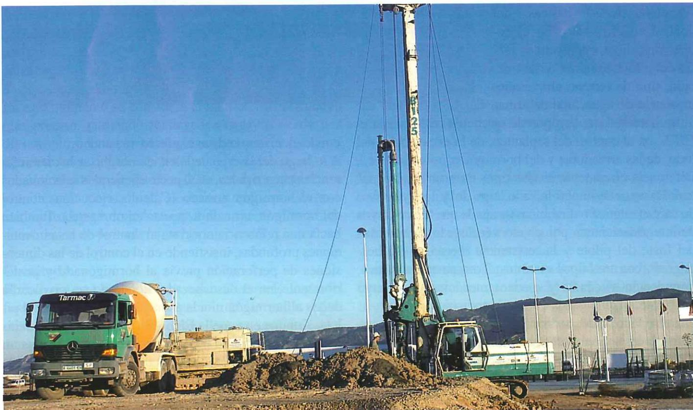
Aspecto general del proceso de ejecución de una cimentación mediante pilotes para una Nave Industrial. Véase el equipo de perforación y el montaje de las armaduras, así como el suministro para el hormigonado
