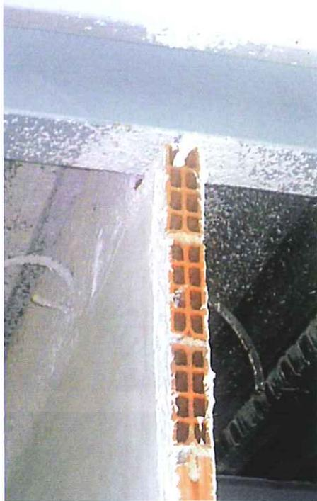
*Un punto crítico habitual lo conforman los elementos de tabiquería, en su unión con los elementos de la estructura metálica, por efecto de las deformaciones estructurales (generalmente flechas de forjado – vigas de acero) y por efecto de las dilataciones entre los distintos materiales*
