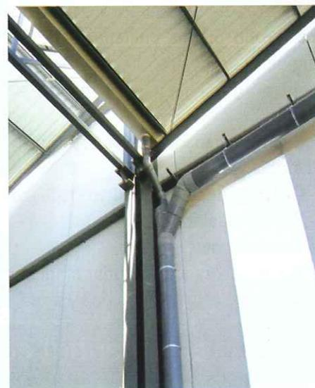
*Es imprescindible inspeccionar los puntos de riesgo en las conexiones entre piezas de PVC. (codos, imbornales, bajantes, etc.) de las instalaciones y su unión con los elementos estructurales y con las placas de cerramiento, para garantizar su fijación*
