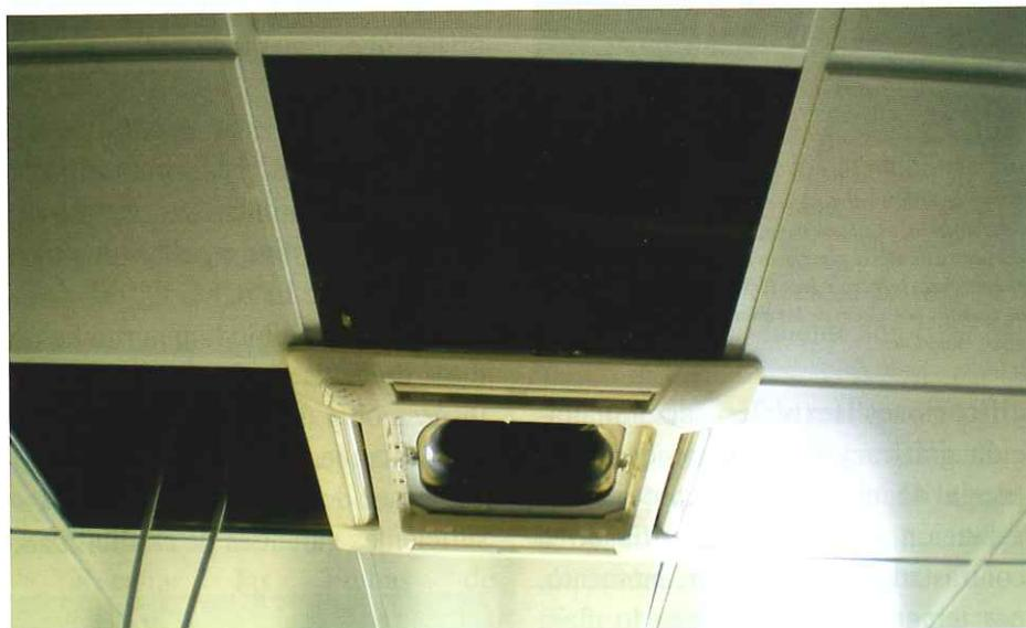
*Las conducciones de aire acondicionado y los equipos de climatización deben estar adecuadamente dimensionados (punto crítico en proyecto) y correctamente fijados al soporte, para evitar daños o lesiones posteriores a la entrega de la obra*
