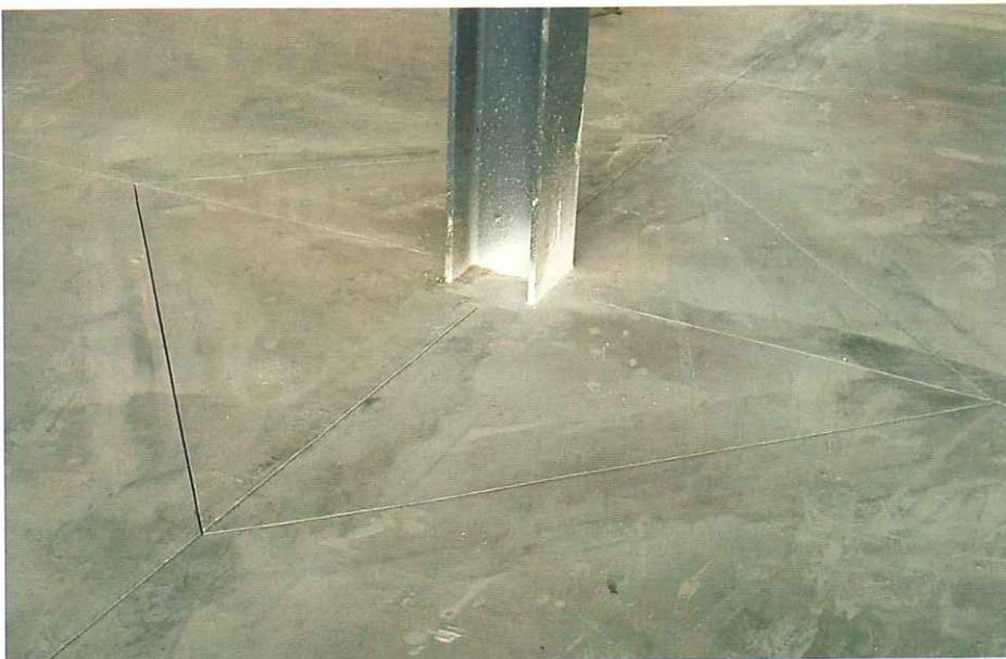
*Es imprescindible ejecutar los pertinentes cortes en solera, como previsión de las juntas de dilatación/retracción y especialmente en su unión con pilares*
