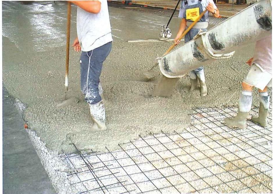
*La posición de las armaduras en solera (generalmente inadecuadamente dispuestas) y los procesos de hormigonado, vibrado, fratasado y curado, suelen constituir un importante punto crítico, objeto de gran número de patologías*
