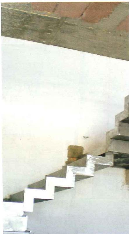
*Detalle de una escalera de acceso a zona de oficinas, donde se deben inspeccionar con mucha atención los puntos de riesgo (I.P.R.), en el apoyo y arranque de la zanca*
