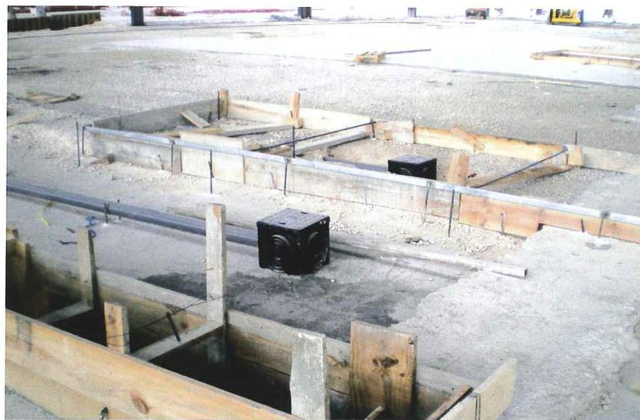
*Los pozos de registro, pozos de producción, arquetas y otros elementos singulares, provocan un importante punto crítico, cuya deficiente ejecución puede acarrear lesiones posteriores en el interior de la nave.*
