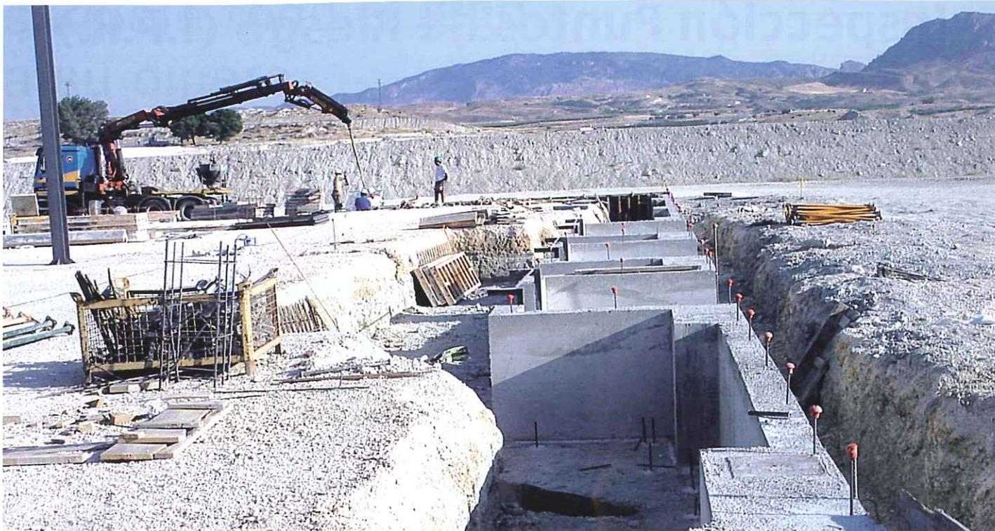
*Es imprescindible un especial cuidado en la compactación del terreno, en el entorno de muros, zapatas, correas y otros elementos estructurales de hormigón de nuestras naves.*
