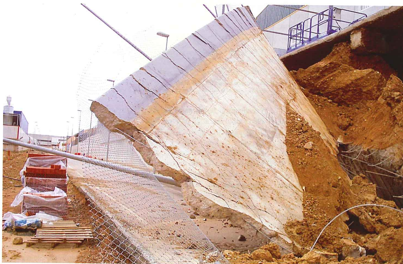
Dos aspectos del estado que presentaba un muro de contención esbelto, tras su derrumbe, con importantes daños materiales. Véase el trazado de las grietas y su deformación
