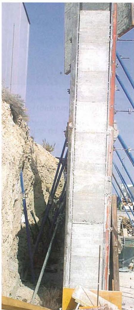
Detalle del proceso de ejecución de un nuevo muro de contención. Véase el espacio previsto para el relleno de material granular y las correspondientes actuaciones de previsión del drenaje
