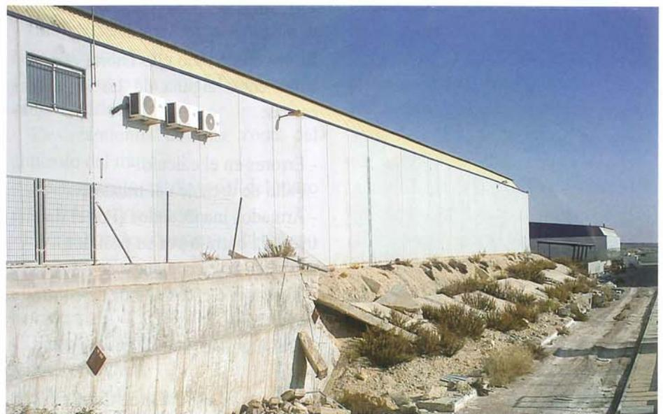
Aspecto del colapso de un muro de contención, junto a una Nave Industrial en servicio. Véase el estado del derrumbe
