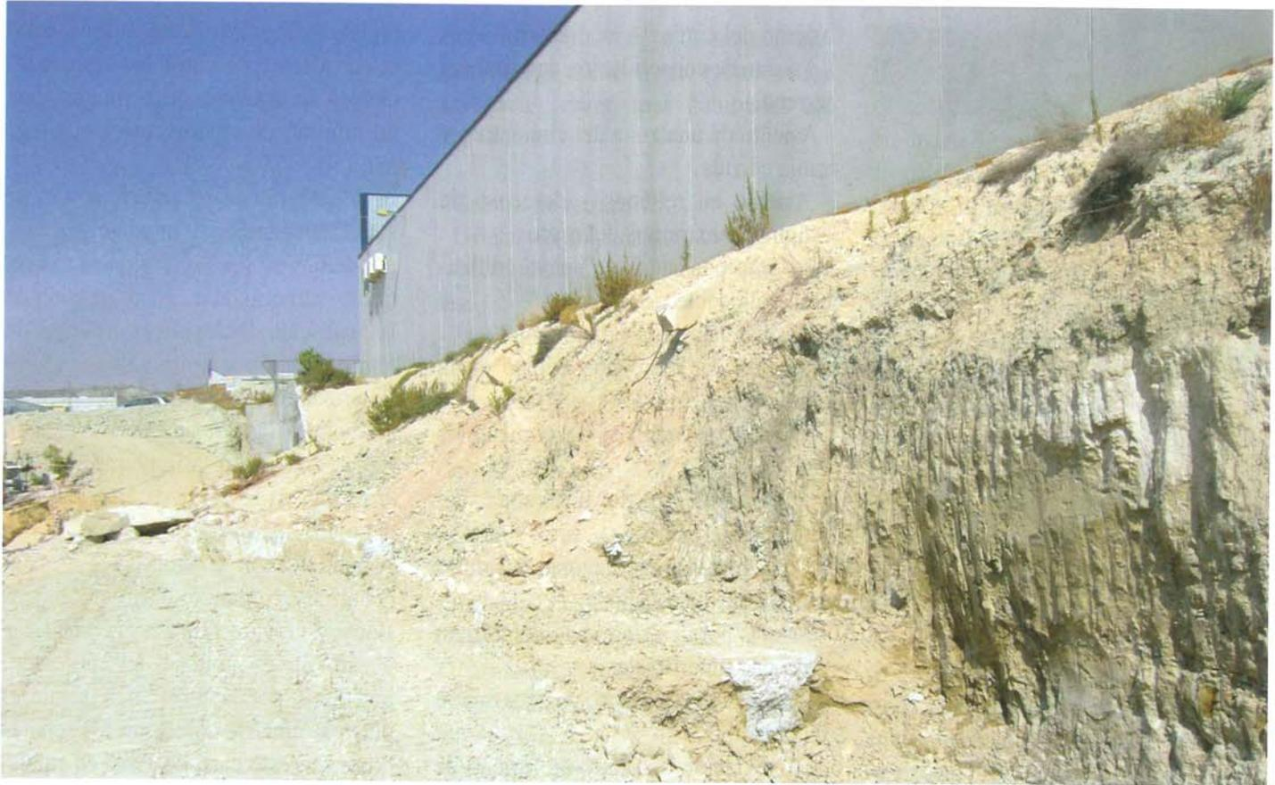
Detalle del proceso de excavación y preparación del terreno, para la ejecución de un nuevo muro de hormigón. Véase la necesidad de excavación por "bataches", para asegurar la estabilidad de la nave, actualmente en servicio
