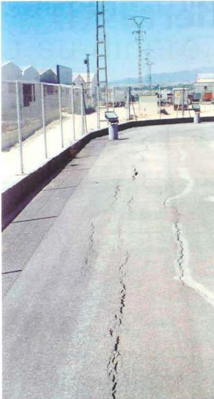
Detalle de las grietas aparecidas en vial del entorno de una Nave Industrial, por desplazamiento horizontal en coronación – “cabeceo”, del muro de contención
