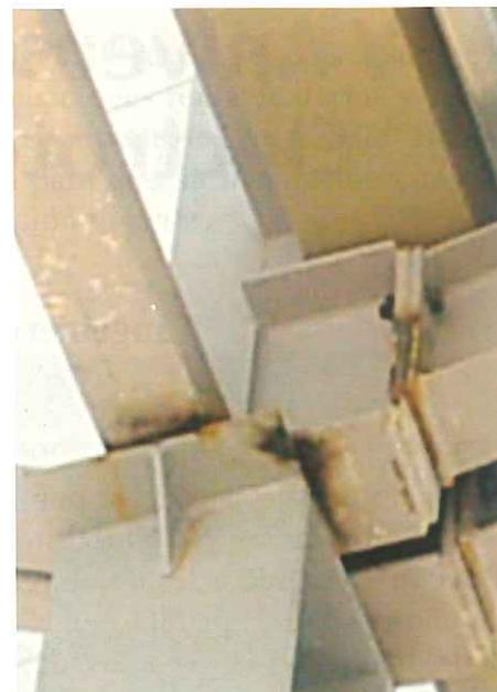
*Detalle de un complicado nudo estructural, que ha necesitado una importante labor de control de replanteos, de ejecución y de comprobación de la calidad de los distintos cordones de soldadura que lo componen*
