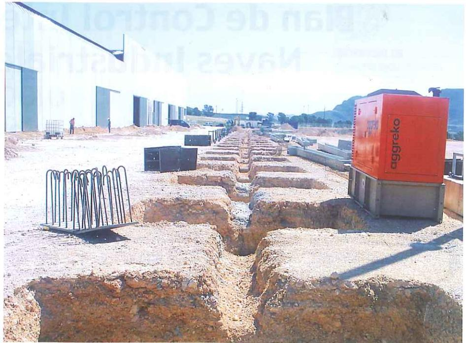
*Detalle del proceso de excavación, comprobación de la tipología y características del terreno, durante el proceso de ejecución de la cimentación. Véanse alineaciones, placas de anclaje, etc*
