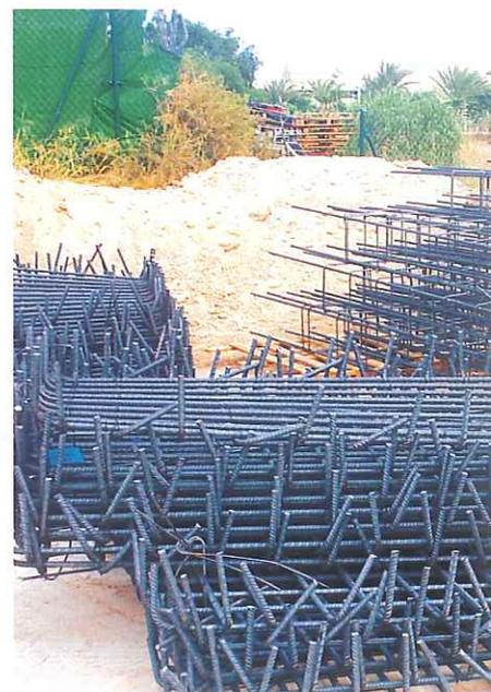
Aspecto general del acopio de armaduras para la cimentación de una Nave Industrial, sometida a un completo Plan de Control
