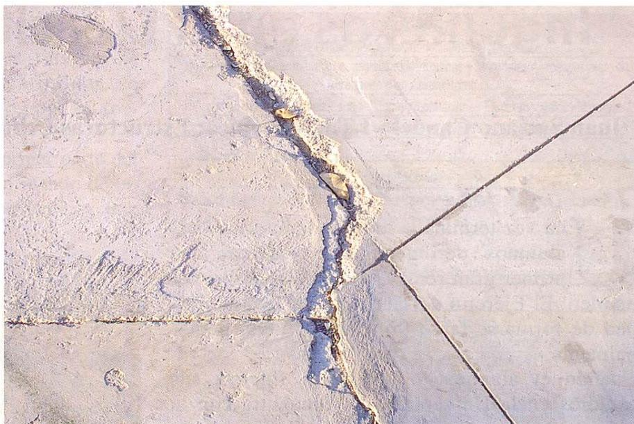
*Detalle de una zona de solera donde se inició el proceso de asiento, por una deficiente compactación de terreno de base de apoyo de la solera de hormigón*
