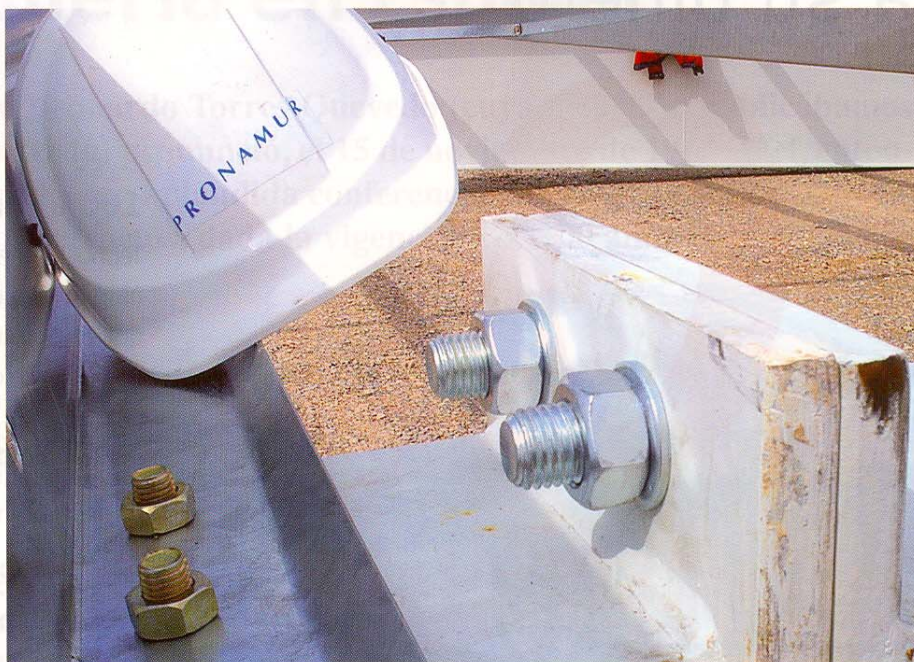
Detalle de una unión estructural resuelta con tornillería. Véase la precisión en el montaje y la facilidad para su control y supervisión
