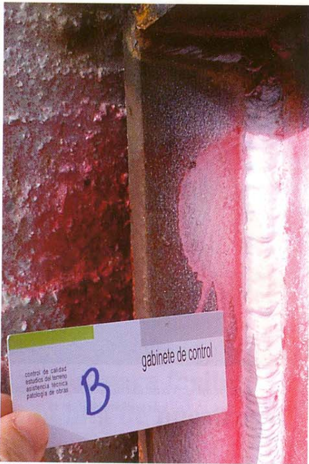
Detalle de un cordón de soldadura, durante el proceso de ensayo, donde se aprecia su correcta ejecución. Véase su uniforme trazado
