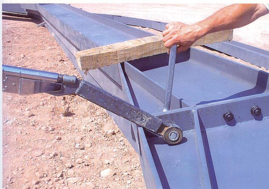
Detalle de un nudo de coronación de pórtico de estructura metálica, resuelto mediante unión atornillada. Véase el momento de comprobación del par de apriete, mediante llave dinamo métrica
