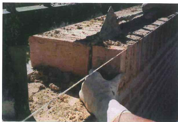
Detalle procedo de ejecución de muro de cerramiento
