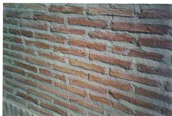
Aspecto general del acabado de un paño de fachada.
