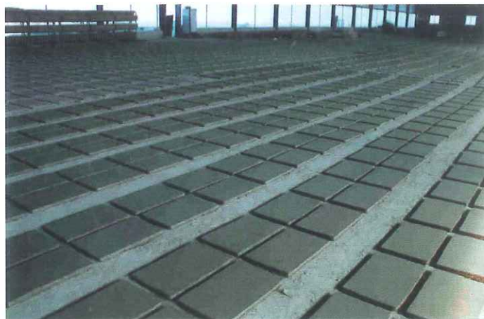
Plataforma de fabricación: Suelo de la nave
