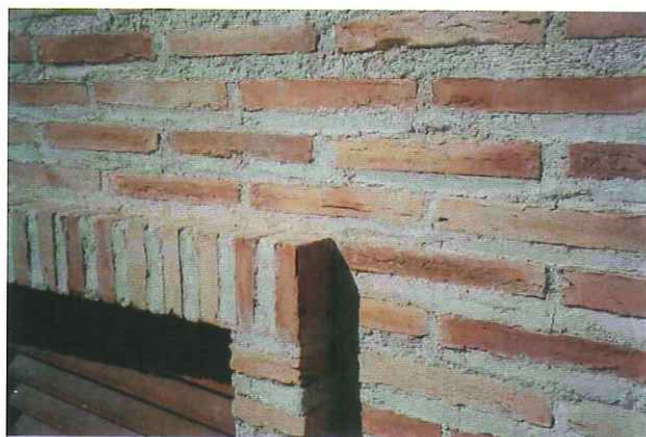
Detalle de acabado del dintel de un hueco de puerta – ventana
