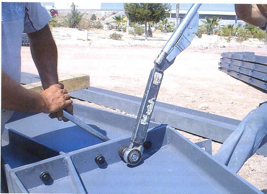
Detalle de un nudo de coronación de un pórtico de estructura metálica, resuelto mediante unión atornillada. Véase el momento de comprobación del par de apriete, mediante llave dinamométrica
