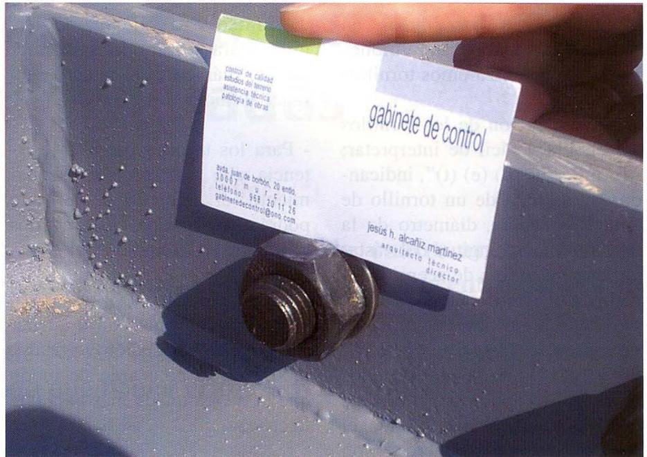
Detalle de la preparación de una de las uniones atornilladas en un pórtico de estructura metálica. Véase el espárrago y la tuerca, con su arandela de conexión
