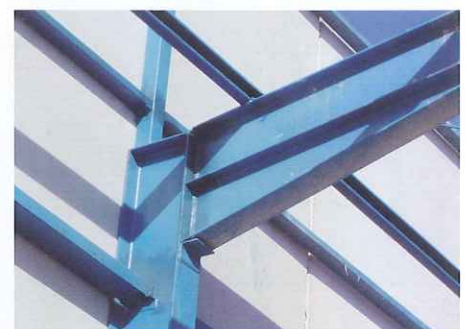
Detalle de apoyo de estructura porticada sobre pilar lateral, unida mediante cordón vertical de soldadura
