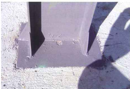
Detalle de unión de pilar metálico sobre placa de anclaje, en zapata de cimentación, resuelto con cordón continuo de soldadura, realizada "in situ", en posición horizontal
