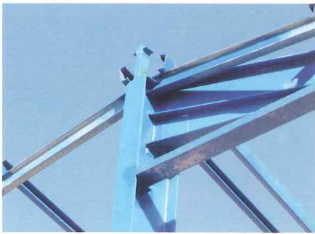
Aspecto estructural de un importante nudo resuelto mediante unión soldada, en uno de los pórticos metálicos estudiados
