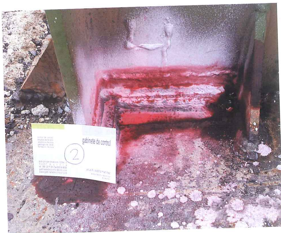
Detalle de la comprobación de la calidad de un cordón de soldaduras, mediante la aplicación de Líquidos Penetrantes. Véanse los defectos detectados
