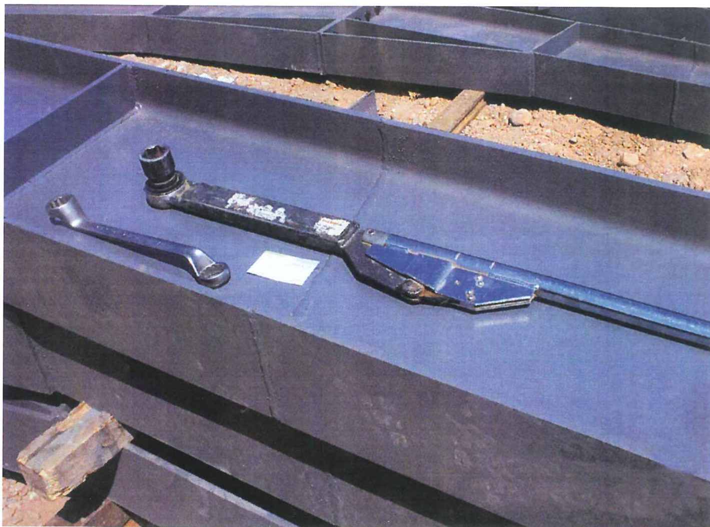
Detalle de la llave dinamométrica utilizada para la comprobación del par de apriete, en estructura atornillada
