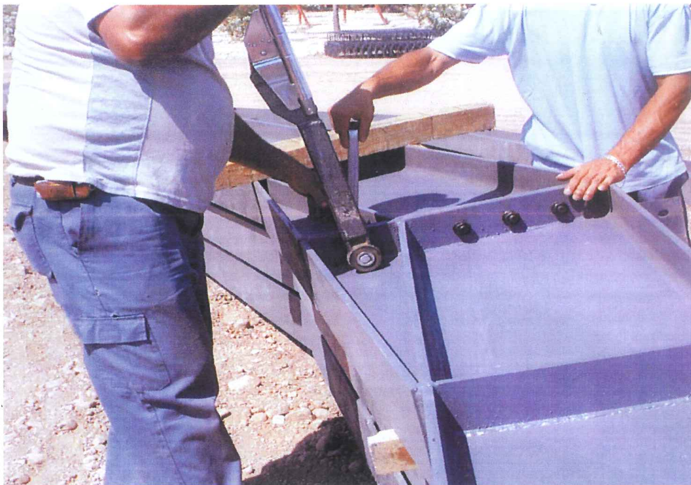
Detalle de un nudo de coronación de pórtico de estructura metálica, resuelto mediante unión atornillada. Véase el momento de comprobación del par de apriete
