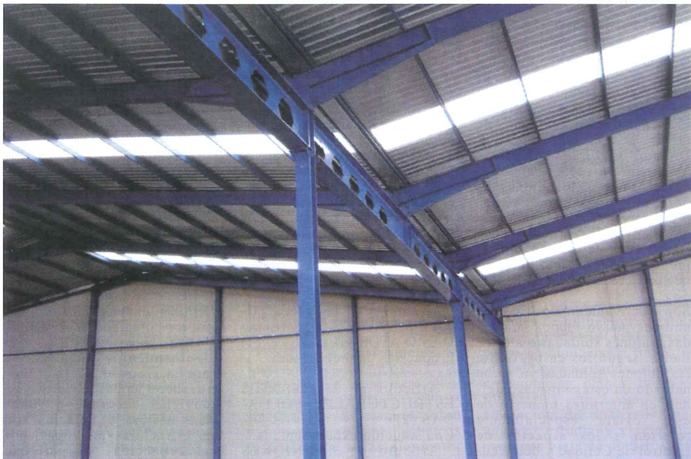
Aspecto general de la cubierta en estructura metálica, resuelta con vigas alveoladas y apoyos con uniones soldadas
