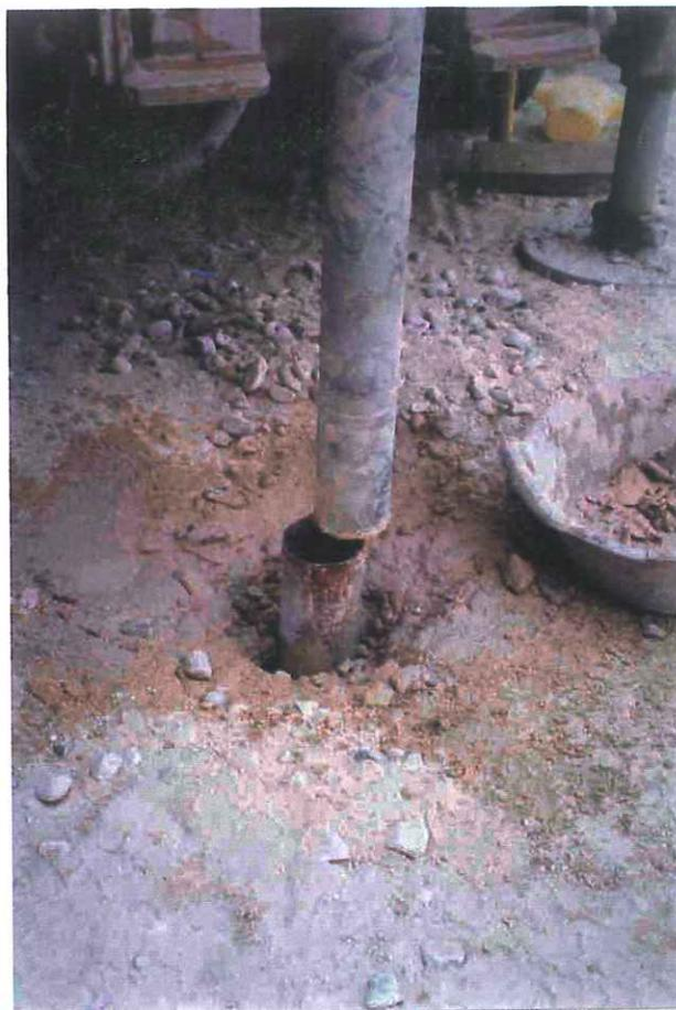
*Detalle de la tubería (para entubación) introducida en el suelo objeto de estudio. Por su interior se introduce la batería que nos va a permitir la toma de muestras.*
